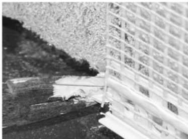
Wyrównanie łącznika profilu
