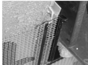
Zamontowany narożnik z łącznikiem Sto-Fugenflankenprofil
